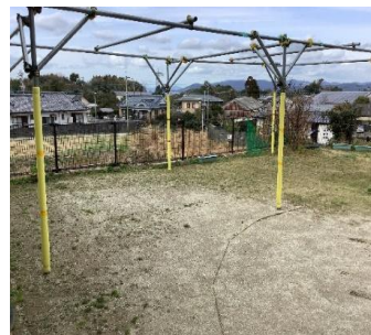
令和7年1月23日に単管パイプカバー 取り付け済。
